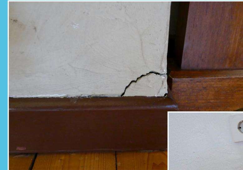
**Des Weiteren sind Risse in der Wand nicht mehr zu verstecken. Diese müssen aufgearbeitet werden, um die Gebäudesubstanz zu erhalten**
